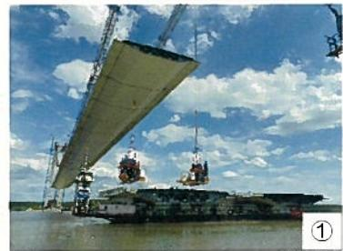
**②技術的向上 - 補剛桁架設用ストランドジャッキのモジュール化**
