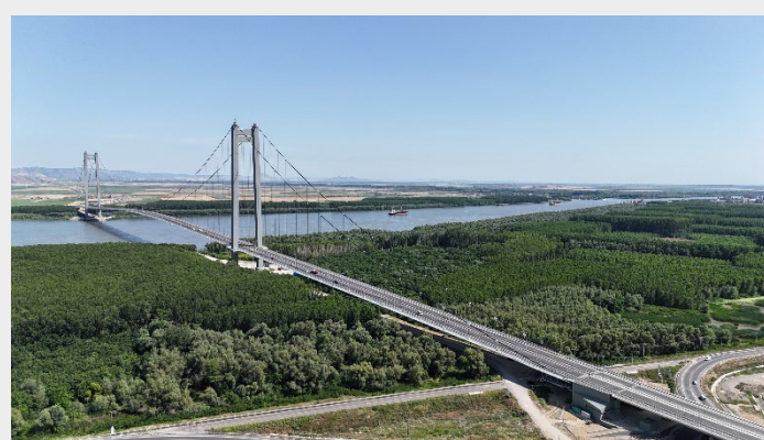
ルーマニア/ドナウ川を跨ぐ吊橋・ブライラ橋の設計および施工
