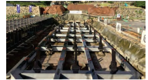
ステンレス製水中梁の施工状況
