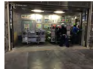
工事用EVへの資材積み込み
