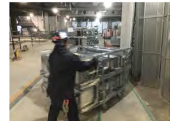
指定箇所への資材の運搬
