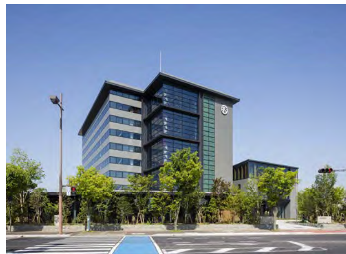
松尾建設本店ビル 2018年 佐賀市
