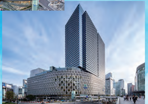
大阪梅田ツインタワーズ・サウスの設計と施工【©母倉写真事務所 母倉知樹】
