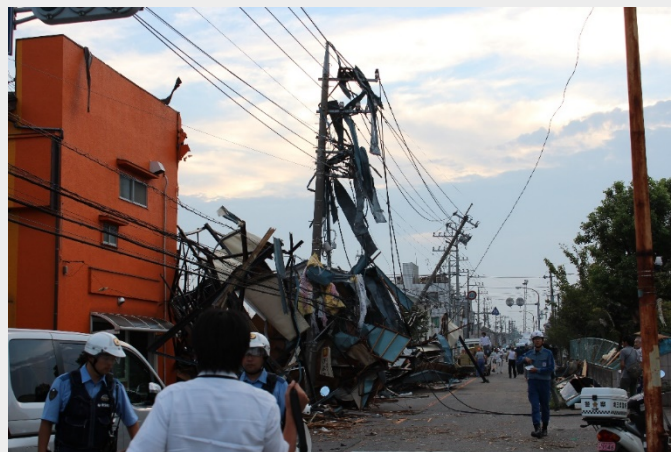
2013 年に発生した竜巻直後の被害状況
