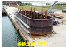
鋼構造物(港湾)
