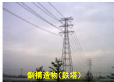
鋼構造物(鉄塔)
