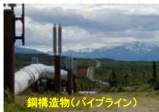
鋼構造物(パイプライン)
